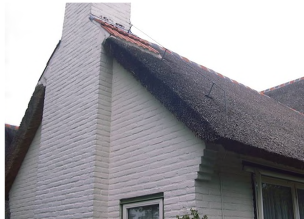
Op deze foto ziet u dat het koperdraad grijs geworden is, waardoor dit minder opvalt.
